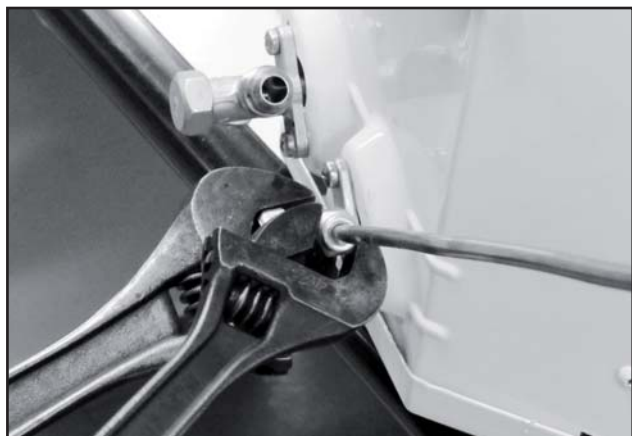
FIGURA 31 - FIJACIÓN DE LA TUERCA
